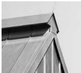
Billede 8: Rygningsafslutning ved vindske, høj udførelse
