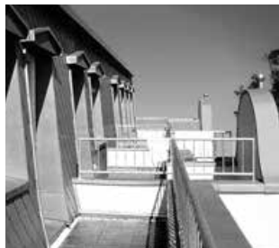
Billede 19: Anvendelse af RHEINZINK-bygningsprofil som muraf-dækning
